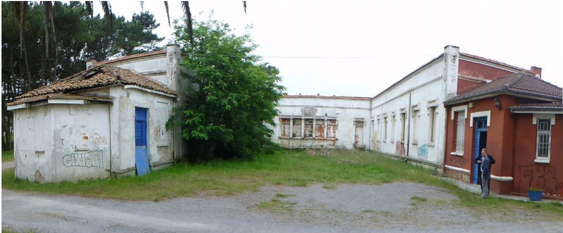
Figura 2: Fachada posterior de Las Colonias en Salinas (Castrillón).
